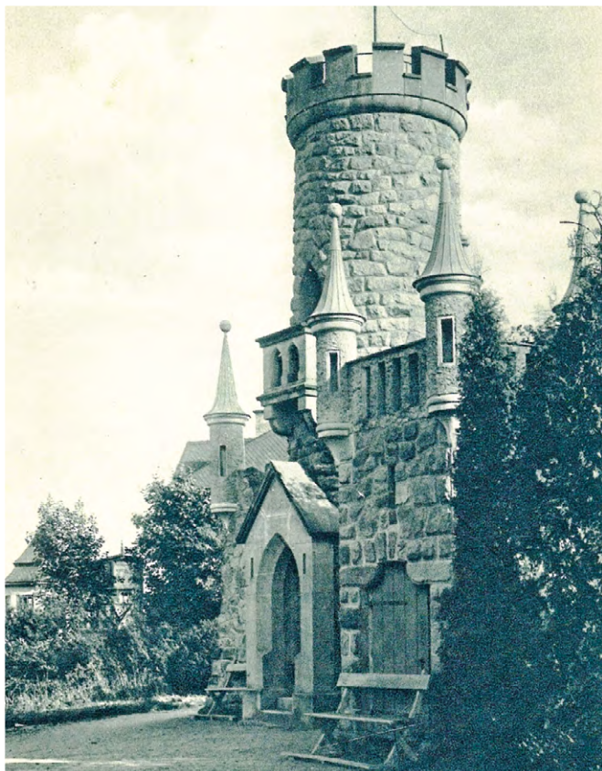
Coby spoluzakladatel, dlouholetý předseda a mecenáš okrašlovacího spolku se Gustav Wiedermann výrazně zasloužil o rozšíření a úpravu františkolázeňských parků. Roku 1906 např. z vlastních prostředků vybudoval rozhlednu Salingburg.
